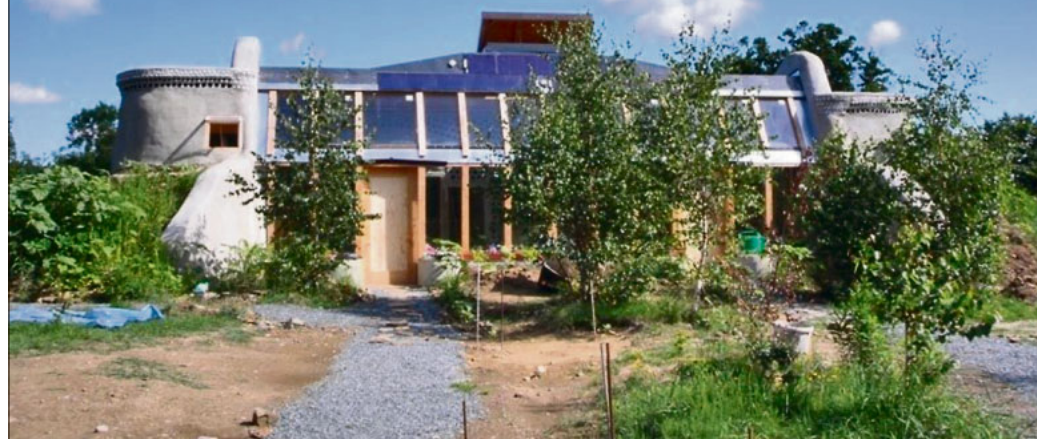
Das Erdschiff von vorn: Die Fensterfront ist sowohl Licht- als auch Wärmequelle.
